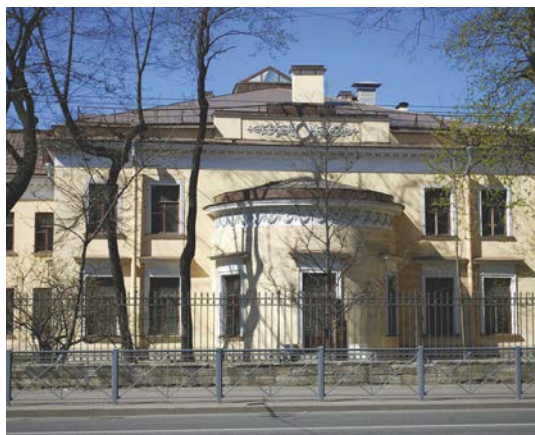
Здание Вольного экономического общества в Санкт-Петербурге
